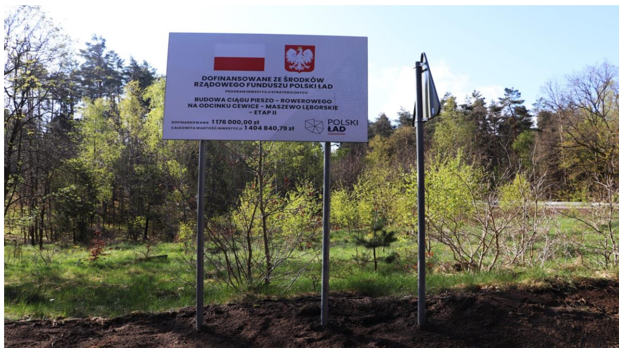
zdj. Tablica informacyjna do oznaczenia inwestycji dofinansowanych z budżetu państwa, źródło: www.cewice.pl
