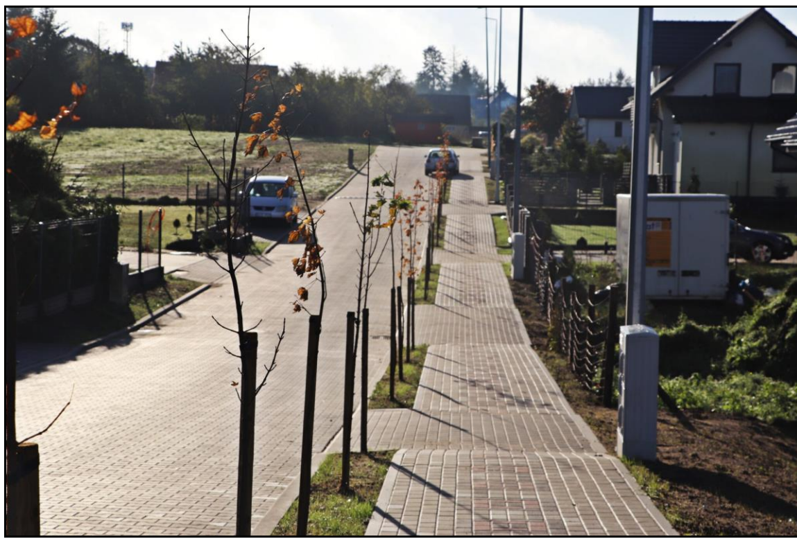
zdj. Nowo wybudowana droga na ul. Kwiatowej w Cewicach, źródło: www.cewice.pl
