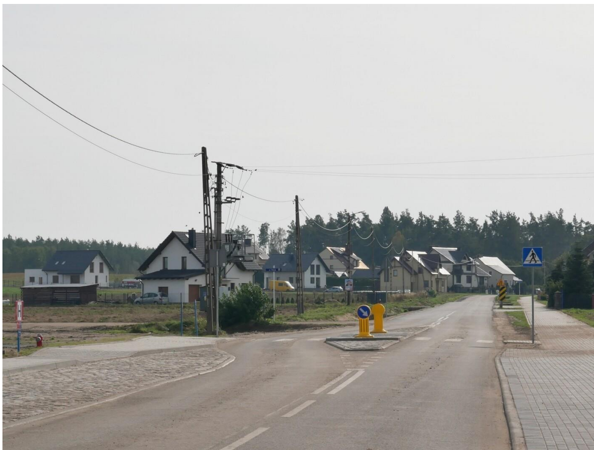
zdj. Przebudowana droga powiatowa nr 1328G w m. Siemirowice, źródło: www.cewice.pl
