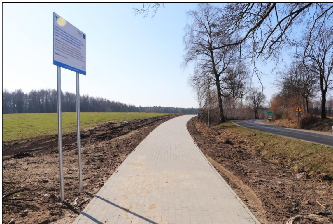
Fot. Infrastruktura rowerowa na trasie Cewice – Kamieniec
