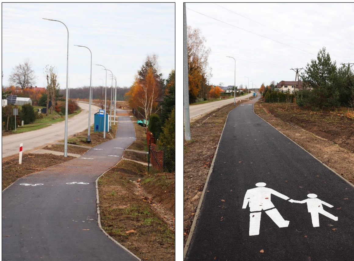
Pierwszy odcinek ścieżki rowerowej na trasie Cewice – Maszewo Lęborskie
