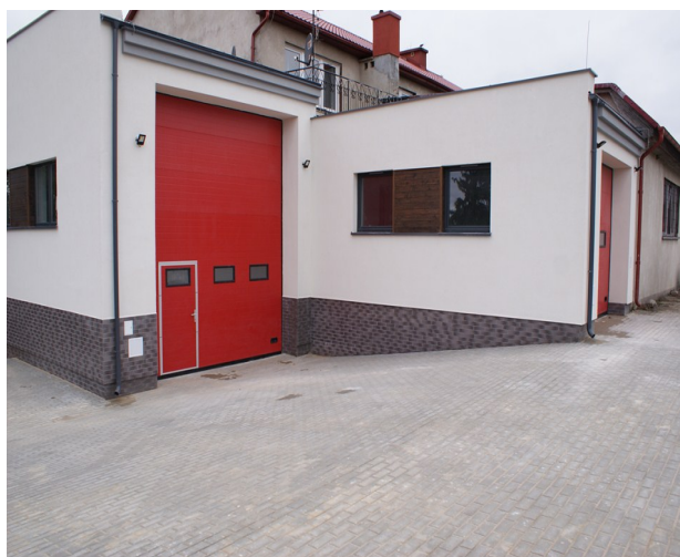
Remiza w Pieskach po remoncie
