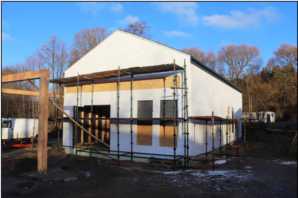
Fot. Budowa świetlicy wiejskiej w Unieszynie.
