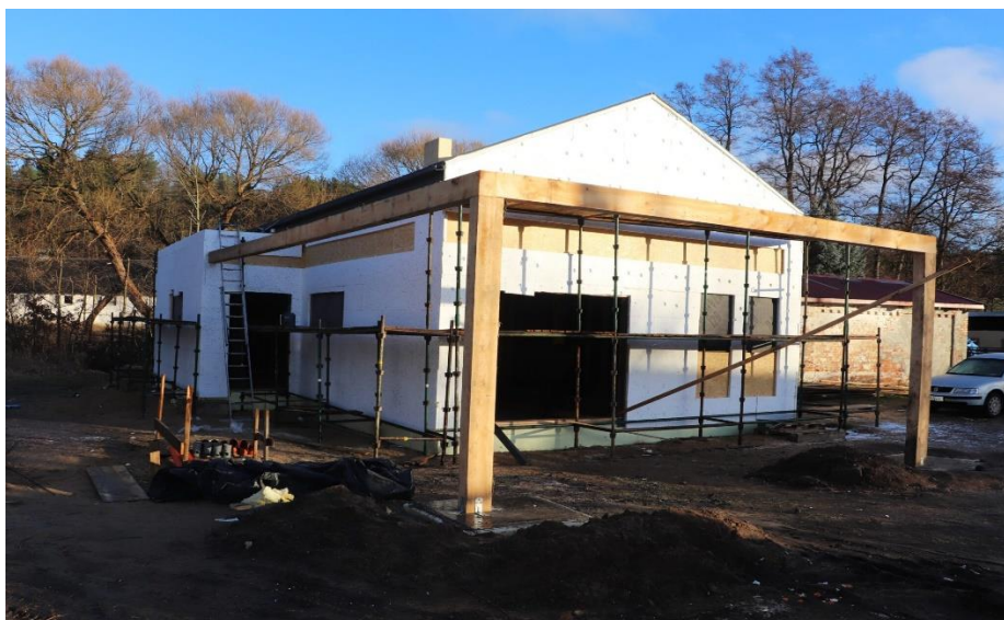
Budowa świetlicy wiejskiej w Unieszynie.
