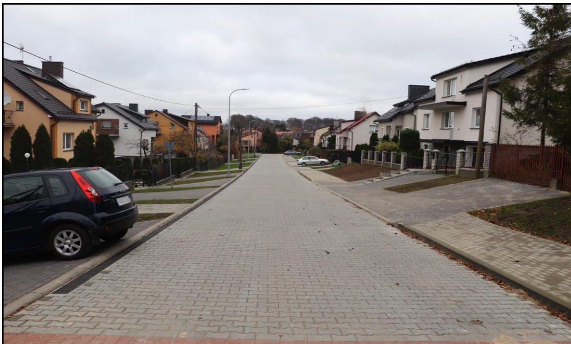
Fot. Nowo wybudowana droga na Osiedlu Młodych w Cewicach.
