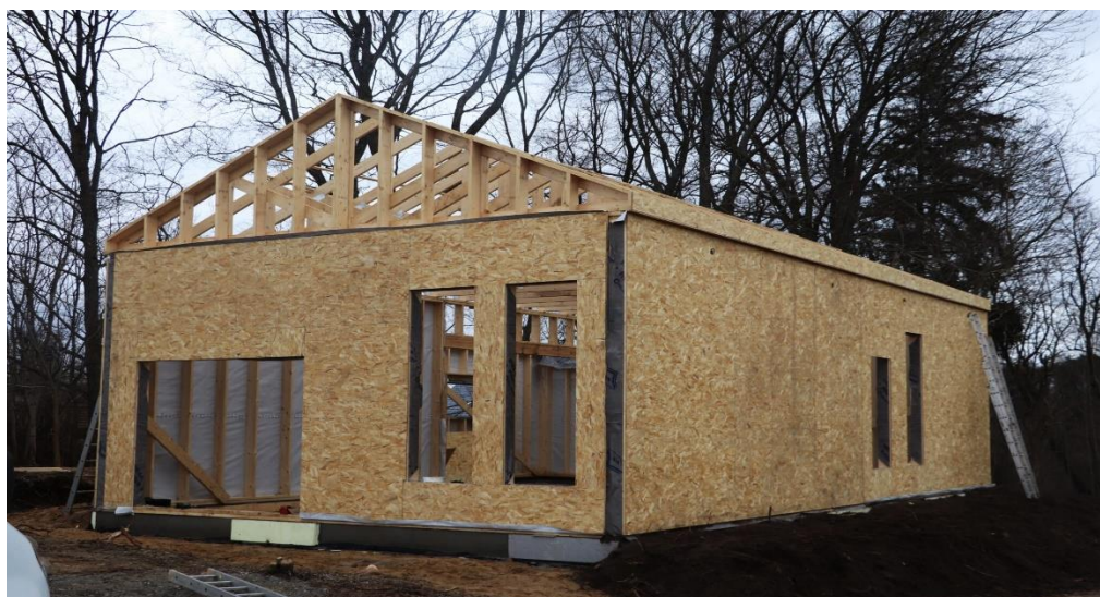
Budowa świetlicy wiejskiej w Oskowie.
