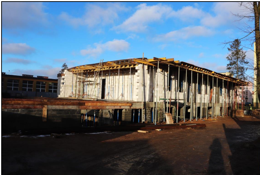
Fot. Rozbudowa szkoły w Siemirowicach.
