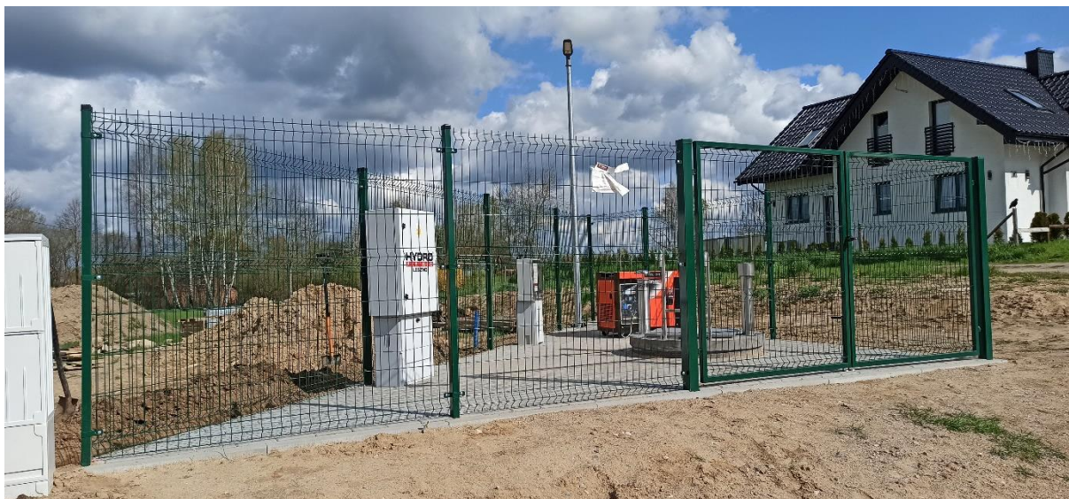
Sieć wodociągowa i kanalizacja sanitarna w m. Łebunia ul. Pomorska.
