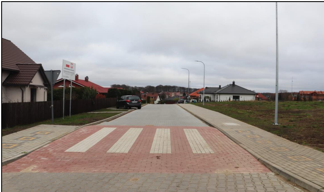
Fot. Nowo wybudowana droga na ul. Akacjowej w Cewicach.
